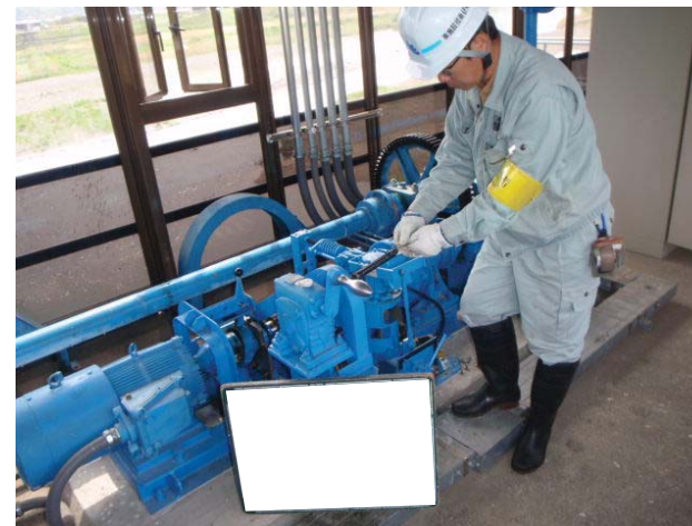
施設の点検の例
