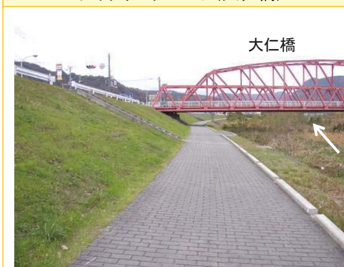
サイクリングロード(大仁橋)
