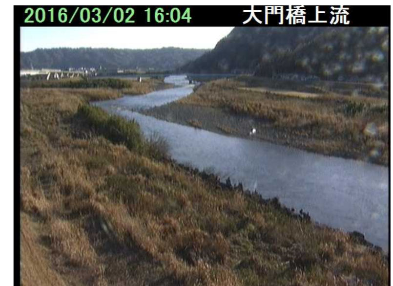
CCTVカメラ映像
