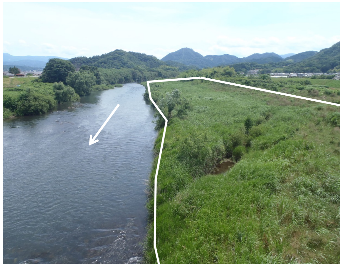
掘削前（平成27年6月撮影）
