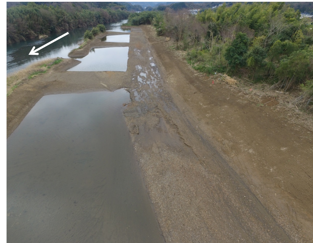
掘削後（平成28年1月撮影）
