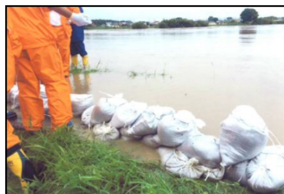
常総市 鬼怒川左岸 (豊水橋付近)積み土のう
