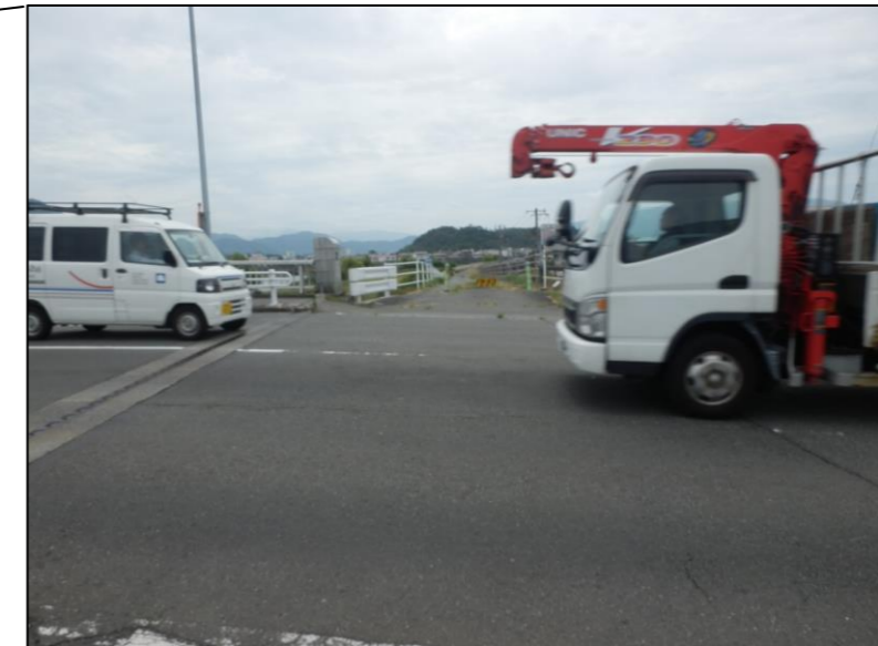
交通量の多い橋梁 (港大橋右岸)
