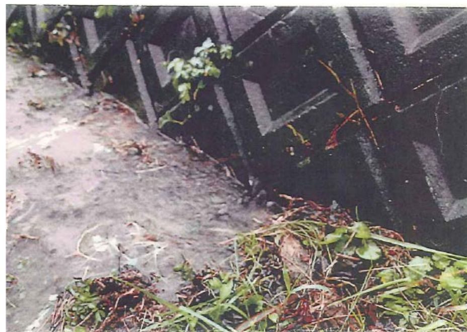
◆平成23年9月の出水における漏水状況。(狩野川左岸27.0k付近)
