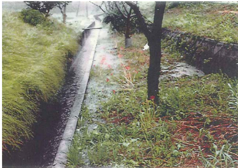
◆平成23年9月の出水における漏水状況。(狩野川左岸27.0k付近)
