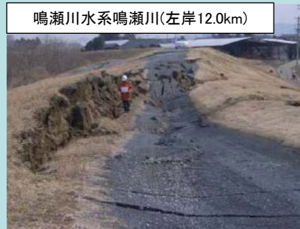
H23 東北地方太平洋沖地震による堤防の被災状況
