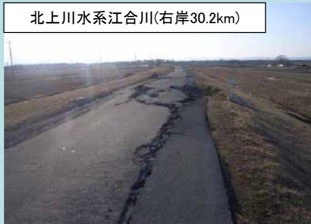
H23 東北地方太平洋沖地震による堤防の被災状況
