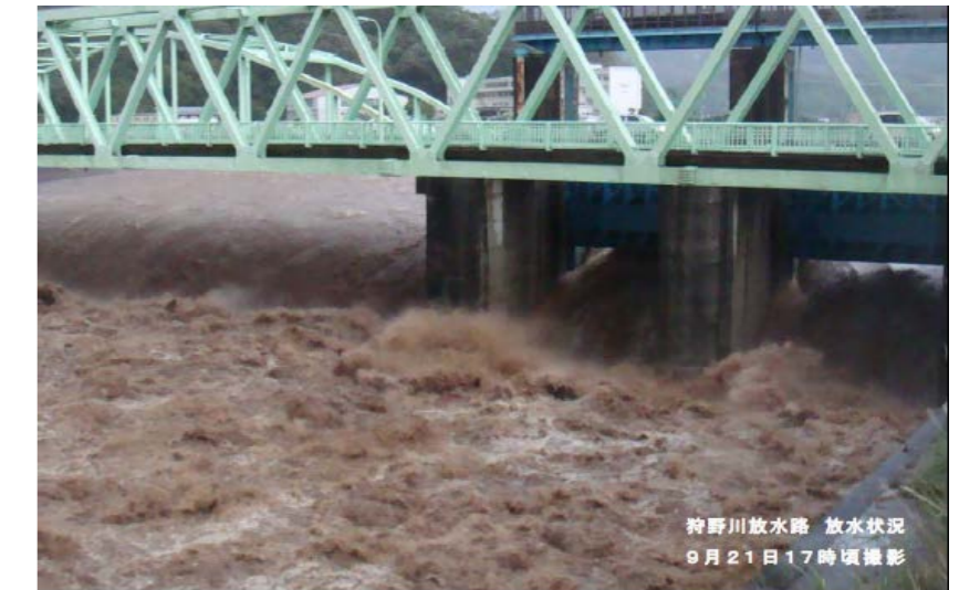
狩野川放水路放流状況 平成23年9月21日17時頃
