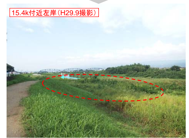
水際で草本類が繁茂している
