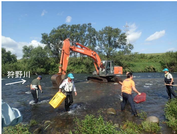
伊豆の国市 宗光寺付近での造成作業 (2017/9/19)
