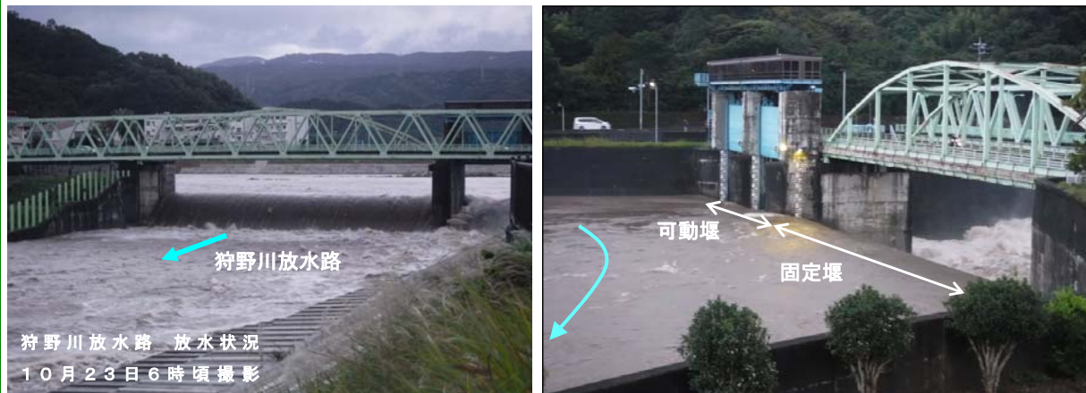
狩野川放水路の放流状況
