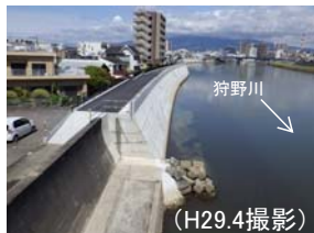
沼津市下河原地区 (施工中)
