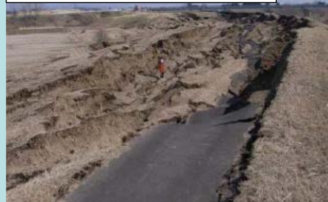
鳴瀬川水系鳴瀬川(左岸30.0km)
