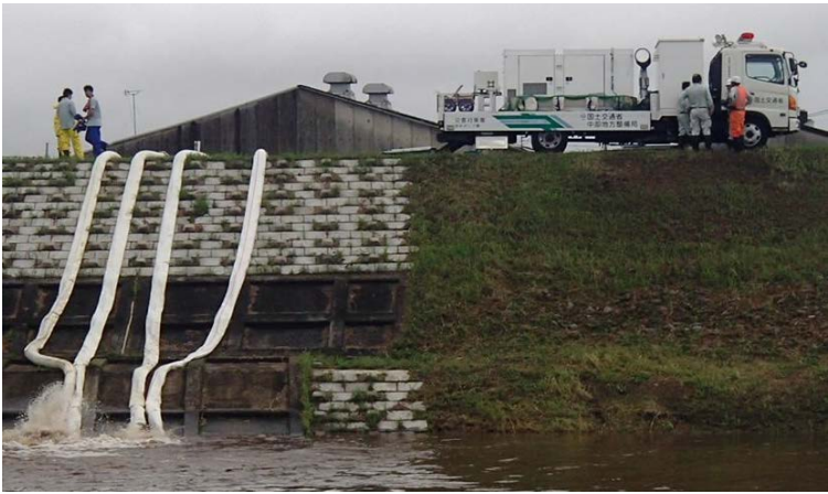
排水ポンプ車による排水状況
