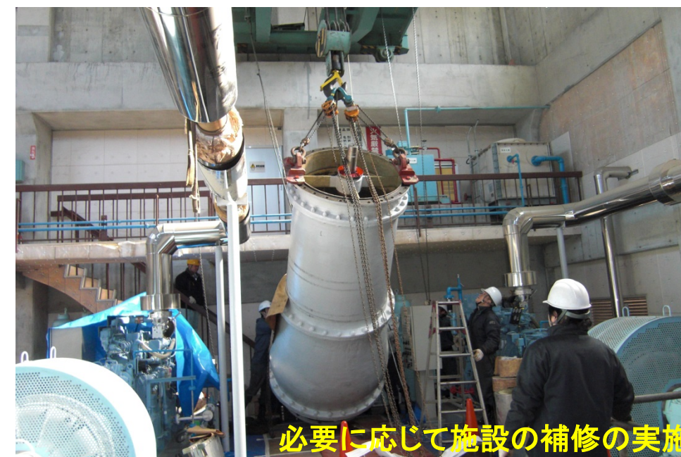
施設の補修状況
