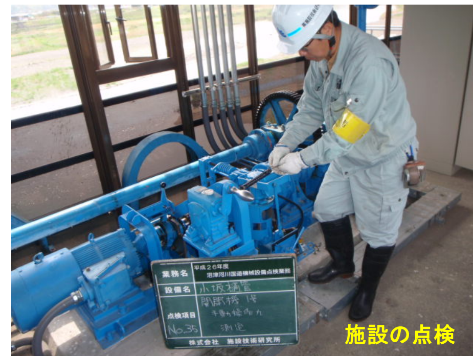
施設の点検状況
