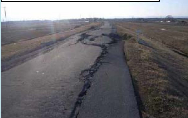
H23 東北地方太平洋沖地震による堤防の被災状況
