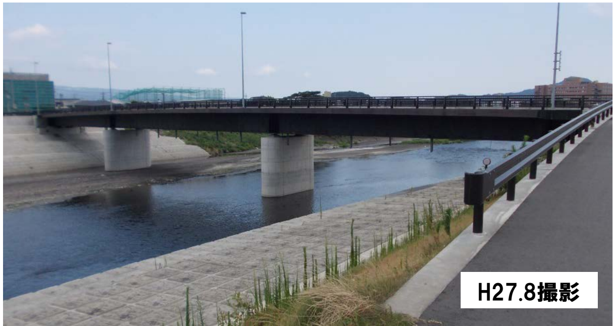
現在の黄瀬川橋【黄瀬川橋改築工事実施後】
