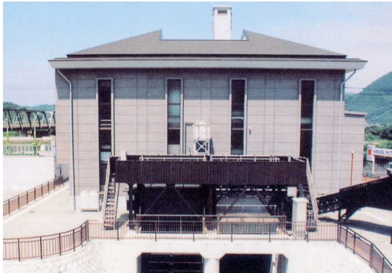
伊豆の国市四日町地区(四日町排水機場)ポンプ増設
