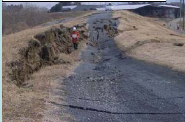
H23 東北地方太平洋沖地震による堤防の被災状況
