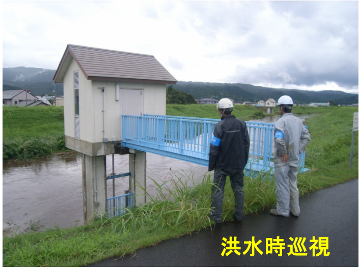
洪水時巡視の実施状況
