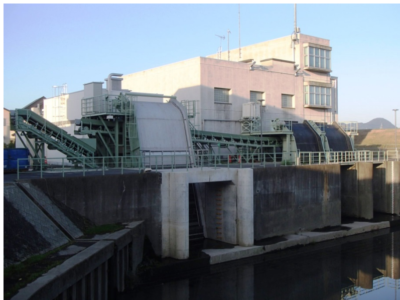
函南町間宮地区(函南観音川排水機場)ポンプ増設
