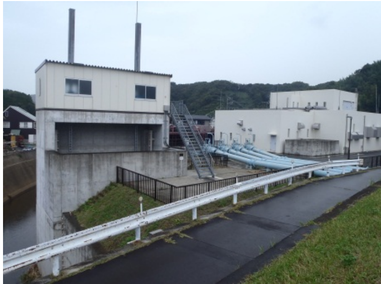
伊豆の国市神島地区(小坂排水機場)ポンプ増設
