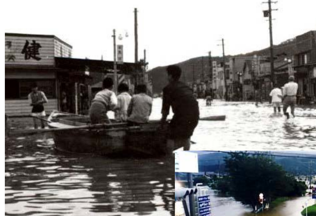
昭和33年9月洪水 (狩野川台風) 沼津市平町
