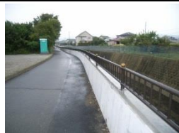
2. 函南観音川護岸高上げ(完了)
