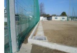
11. 田方農業高校雨水貯留施設(完了)
