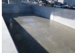
23. 東駿河湾環状道路調整池(県施工区間)(完了)
