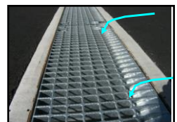
25. 東大場調整池の活用: 横断側溝の設置(完了)
