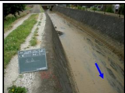
1. 函南観音川排堆積土砂除去(完了)
