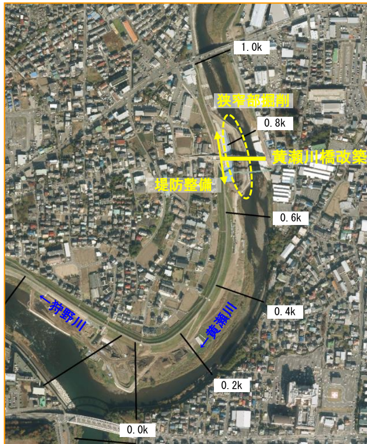
平成18年（整備前）
