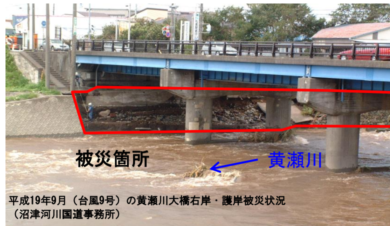
●黄瀬川大橋付近における護岸の被災状況
