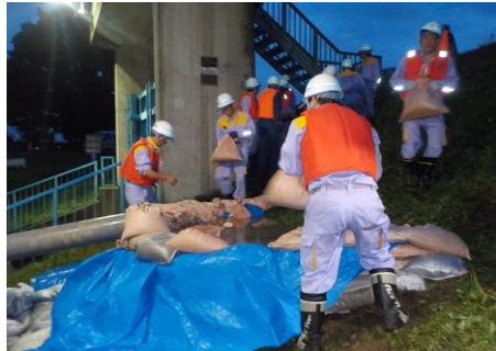
岐阜市水防団 漏水対策
