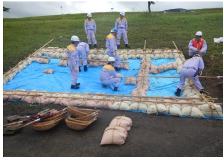
岐阜市水防団 堤防法崩れ対策
