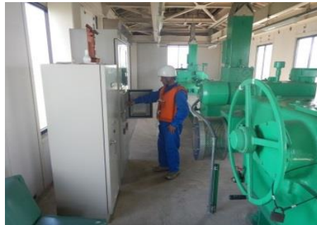
岐阜県 排水樋門の操作
