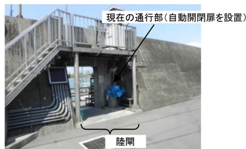
狩野川の我入道第2陸閘と自動開閉装置（堤内側の道路から望む）
