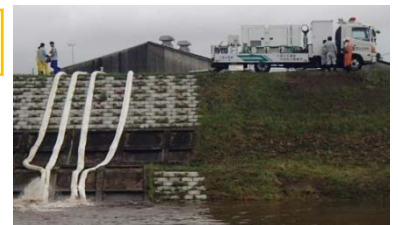
排水ポンプ車による排水状況
