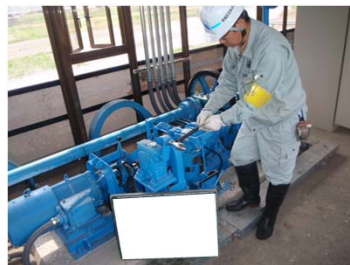
施設の点検の例
