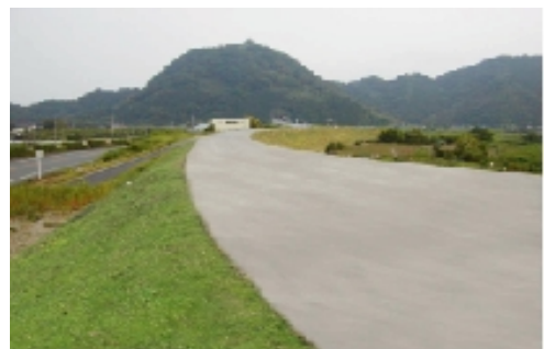
図4.2.9 河道改修イメージ（堤防整備）
