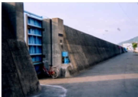
写真2.1.1 左岸の高潮堤及び陸閘
