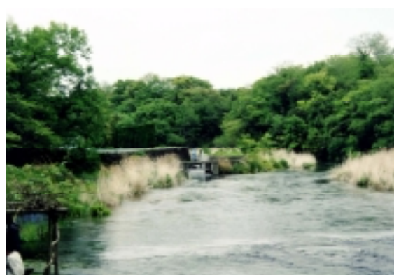
写真1.1.12 駿豆水道取水口
