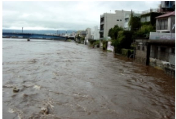
写真1.1.10 平成16年10月洪水 沼津市御成橋下流部の浸水状況
