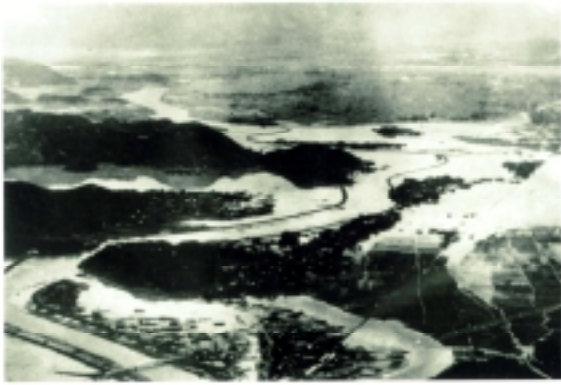
写真1.1.5 昭和33年9月洪水(狩野川台風) 田方平野の浸水(出典:静岡県誌)
