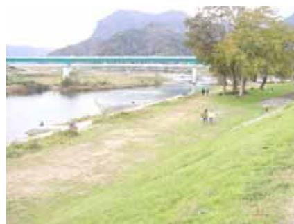
写真4.3.13 天野親水護岸と親水公園 （21.0k付近左岸）
