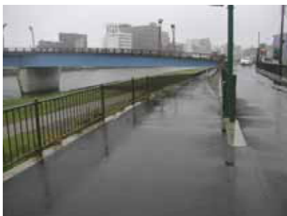
写真4.3.29 アンダーパス(永代橋)
