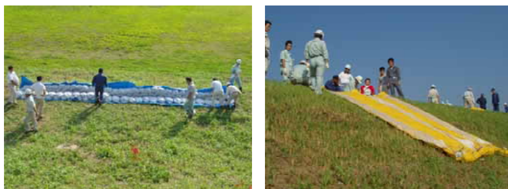
改良積み土のう工
