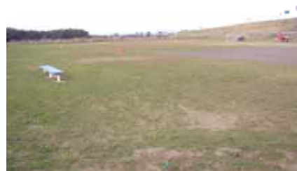
写真4.3.11 高水敷のグラウンド （13.0k付近右岸）
