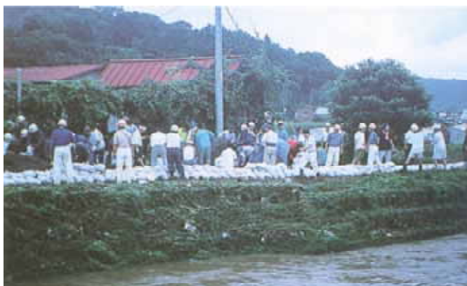
写真4.3.6 平成10年8月30日出水における函南町（柿沢川）での水防活動状況
