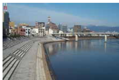
写真4.3.8 上土広場(2.2k付近右岸)
