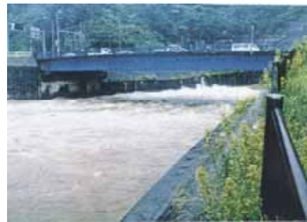
写真4.3.27 洪水時の狩野川放水路
