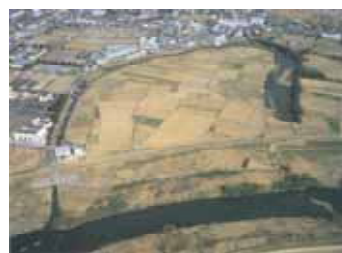
写真4.3.25 河跡湖の状況
