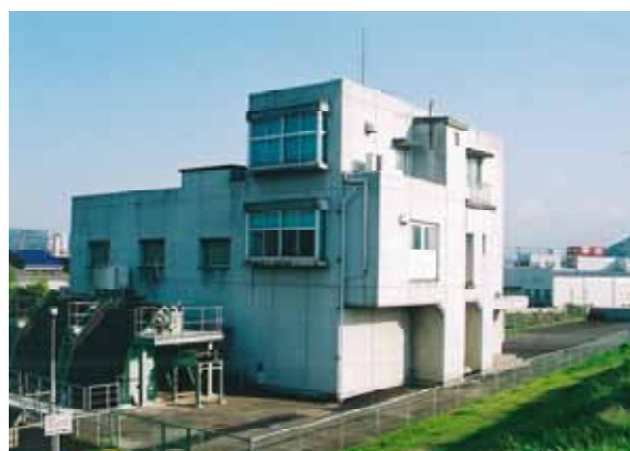
写真4.3.2 函南観音川排水機場
