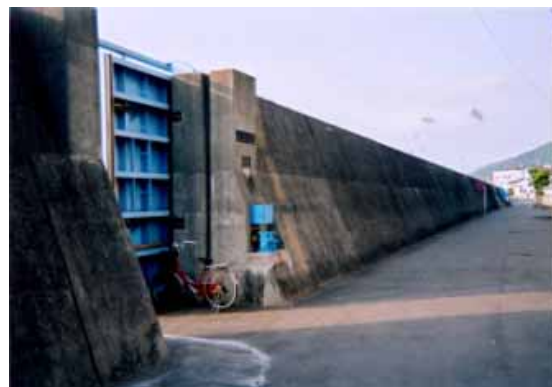
写真2.1.1 左岸の高潮堤及び陸閘
