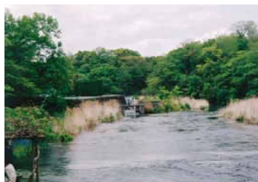
写真1.1.12 駿豆水道取水口
