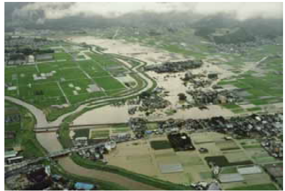
写真1.1.8 平成10年8月洪水 来光川・柿沢川の出水状況
