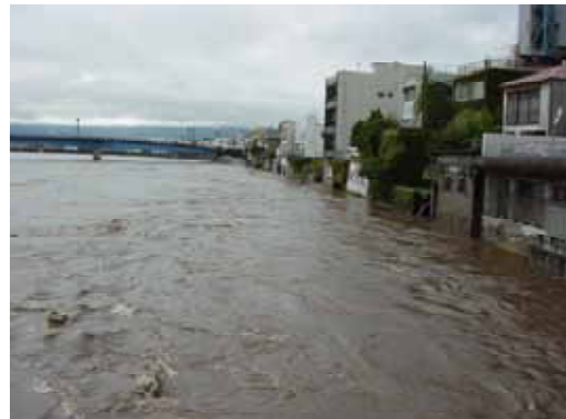
写真1.1.10 平成16年10月洪水 沼津市御成橋下流部の浸水状況
