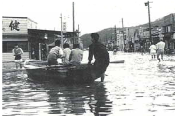
写真1.1.6 昭和33年9月洪水(狩野川台風) 沼津市平町
