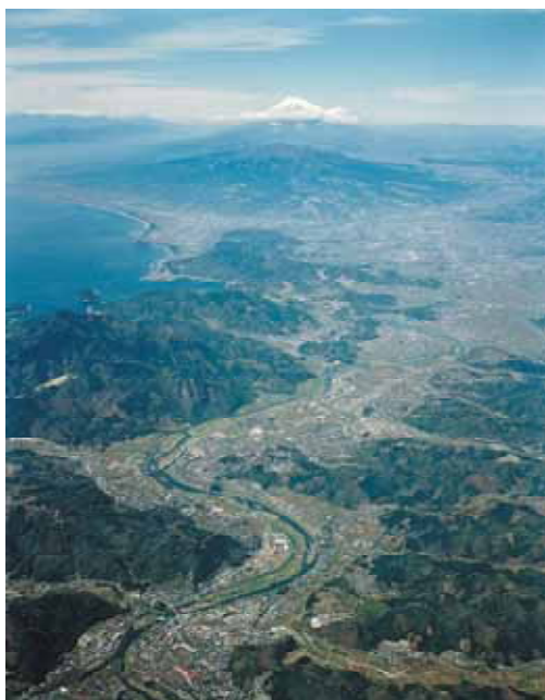
写真1.1.1 伊豆半島上空から見た狩野川
