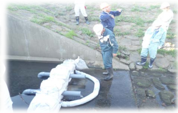
積み土嚢工法
