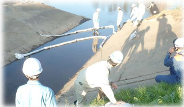
オイルフェンスの設置
