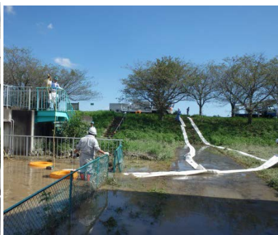
ポンプ排水作業 (鬼怒川支川小貝川)
