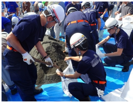
「土のう作り」、「改良積み土のう工法」訓練
