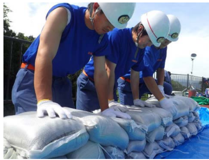
「土のう作り」、「改良積み土のう工法」訓練
