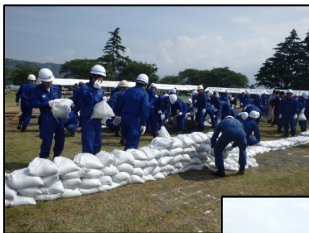
積土のう工法 訓練
