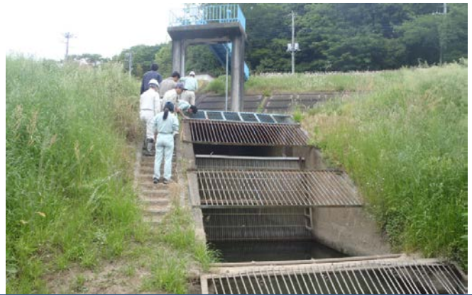
「楠用水の取水口付近」で維持管理状況を確認
