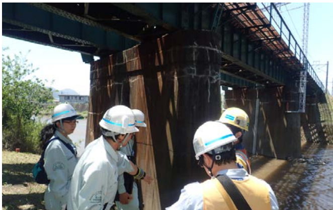
「JR東海道線の橋梁」を高架下から確認
