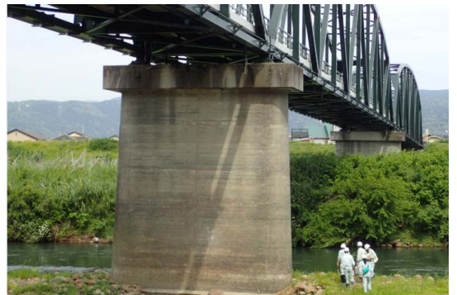
「松原橋の橋脚付近」で洗掘等がないか確認
