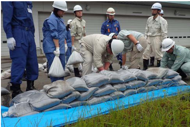
改良積み土のう工法
