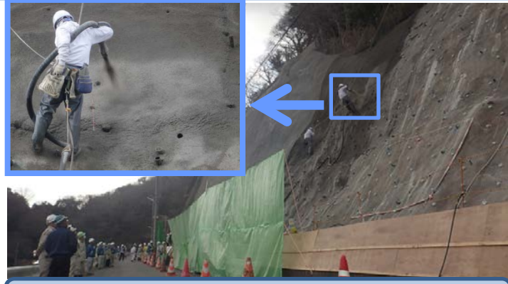
のリフレッシュ工(増厚工)の施工中!
