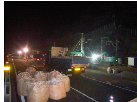
土のう運搬・設置作業
