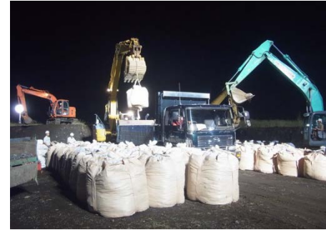
土のう製作現場
