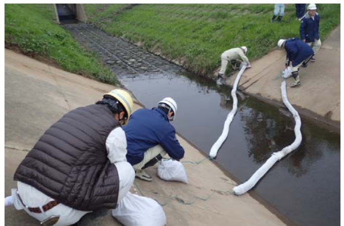
オイルフェンスの設置
