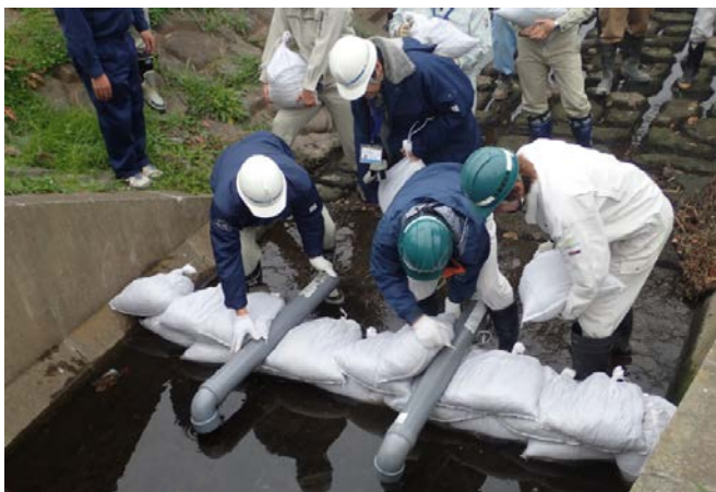
積み土嚢工法
