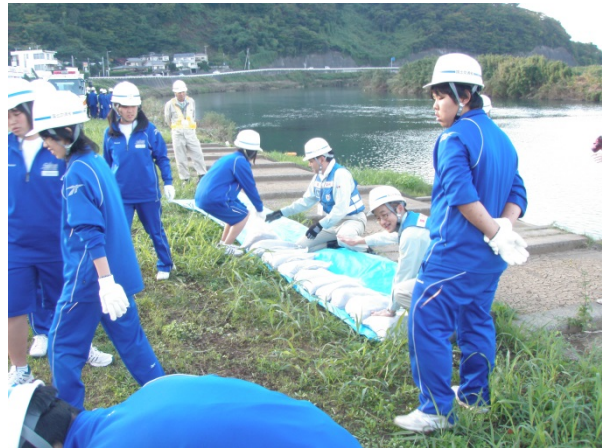
災害時を想定し、狩野川での改良積み土のう工法を体験
