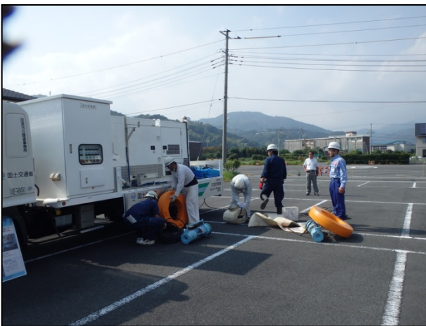
排水ポンプ車の設置
