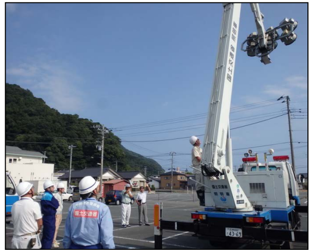
照明車(20m)の設置
