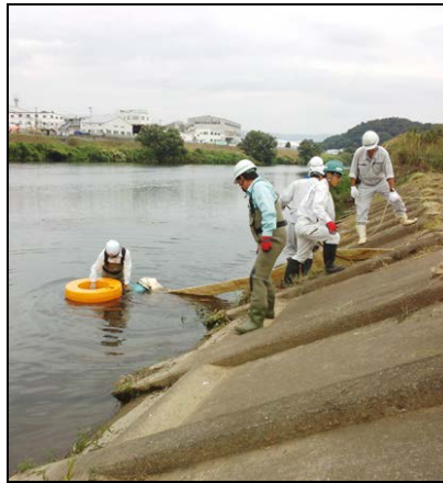
排水ポンプの設置
