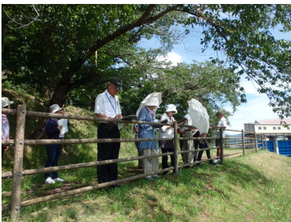
狩野川さくら公園点検状況
