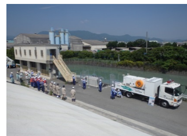
元富士樋管と用水路
