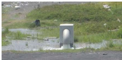
堤防外の排水口
