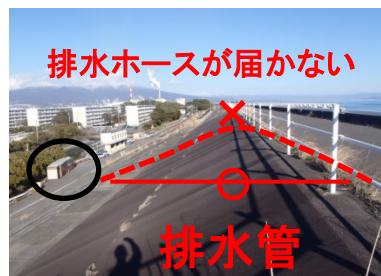
元富士樋管と堤防
