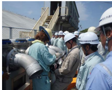
ホースを排水管に接続
