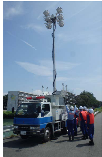
照明車の設置
