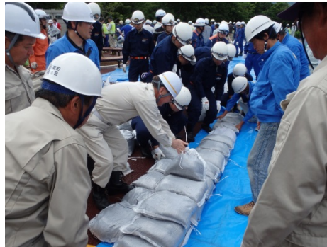
「土のう作り」、「改良積み土のう工法」訓練
