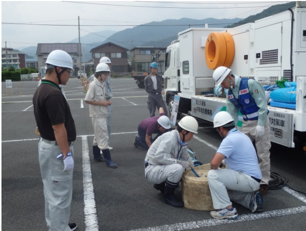
排水ポンプの設置
