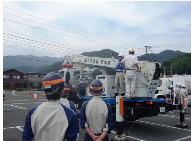
照明車の設置
