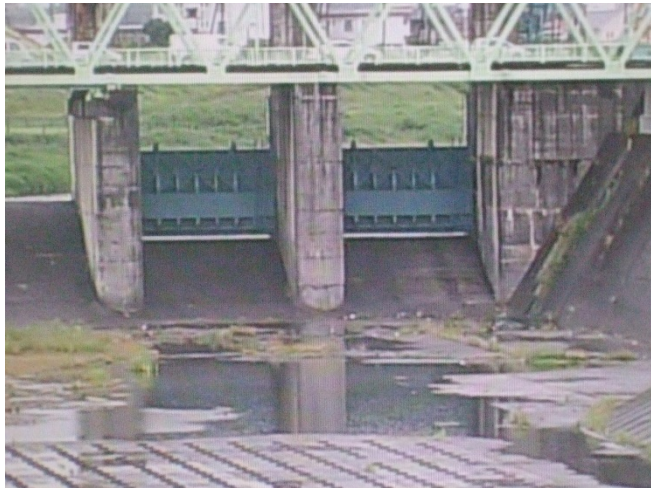
実際に分流堰を操作し手順を確認
