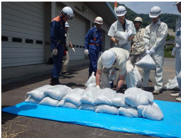
改良積み土のう工
