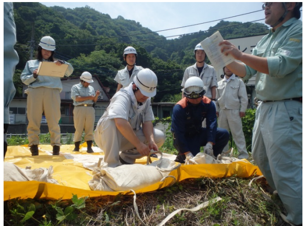
水防マット工
