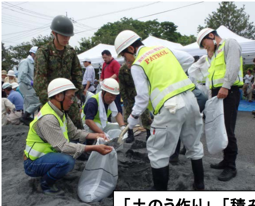
「土のう作り」、「積み土のう工法」訓練
