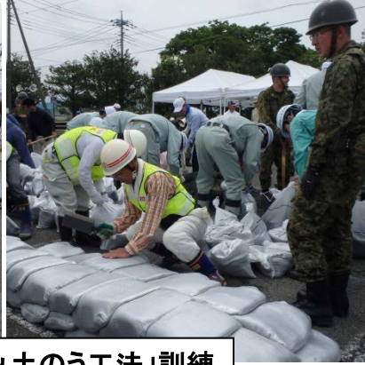
「土のう作り」、「積み土のう工法」訓練
