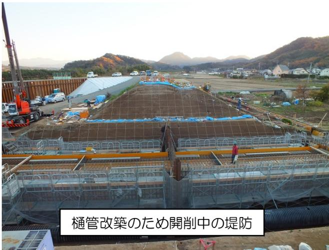
樋管改築のため開削中の堤防
