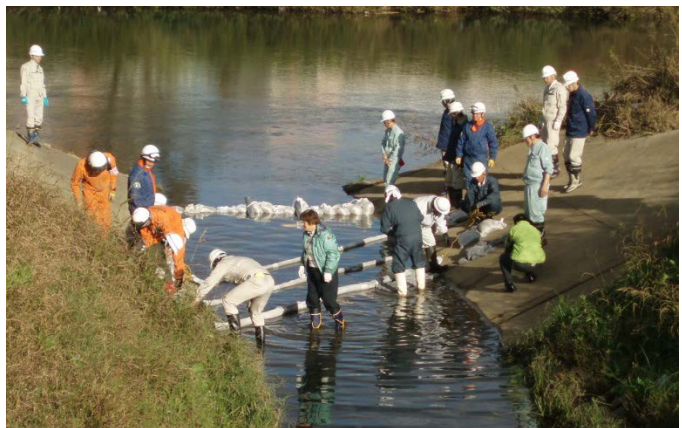
オイルフェンスの設置
