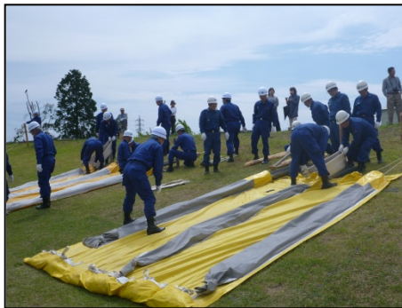
シート張り工法
