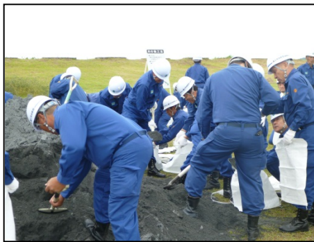
土のう作り・積み土のう工法
