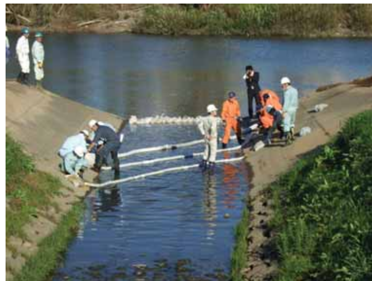
オイルフェンスの設置
