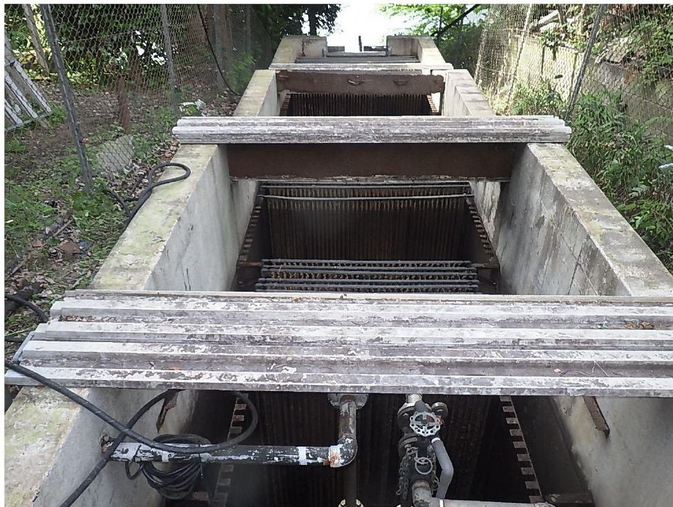
写真：浄化施設の定期清掃作業風景
