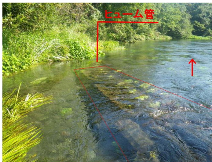
2号排水路による土砂堆積の状況
