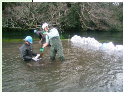
H区における人力施工の状況(H25年度)
