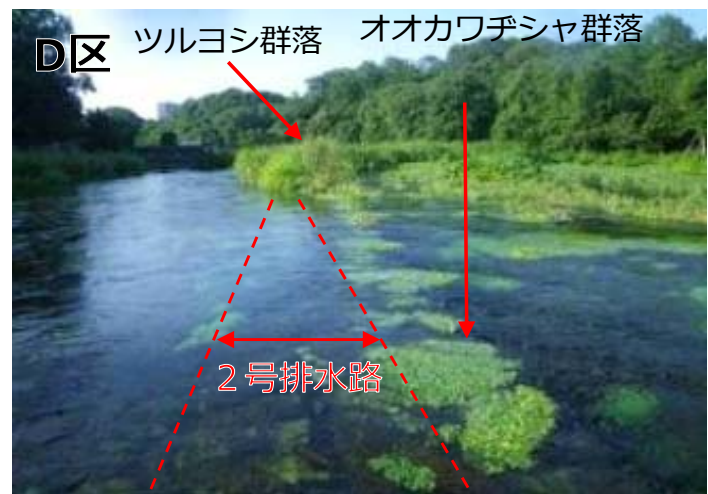
2号排水路による土砂堆積の状況
