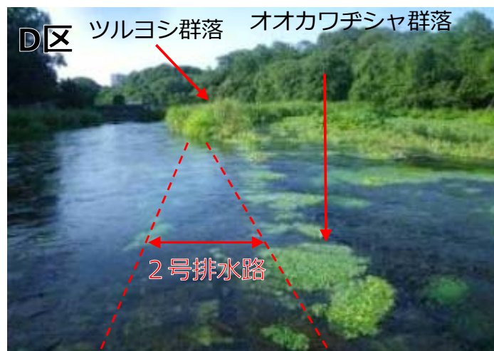
2号排水路による土砂堆積の状況
