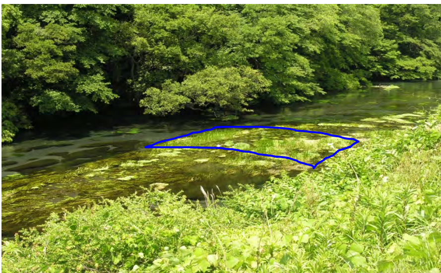
土砂撤去工事前 (2013.5.24)
