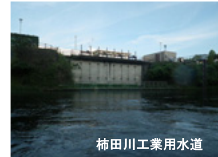
柿田川からの取水状況
