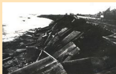
長さ200mにわたって崩壊した海岸堤防(富士市三四軒屋地先)
