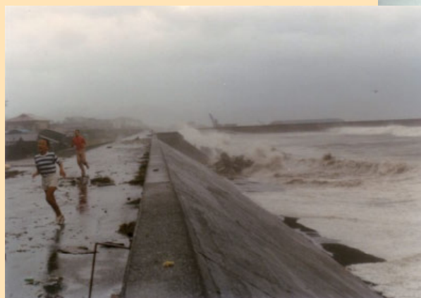
堤防に打ち寄せる高波
