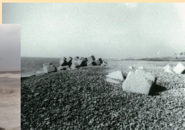
高波により散乱したコンクリートブロック(富士市吉原地先)
