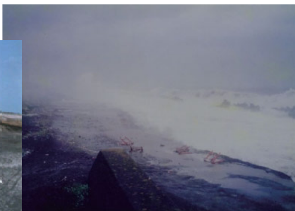
平成29年6月台風第7号。高波によって海岸が削られている。(No.55付近)
