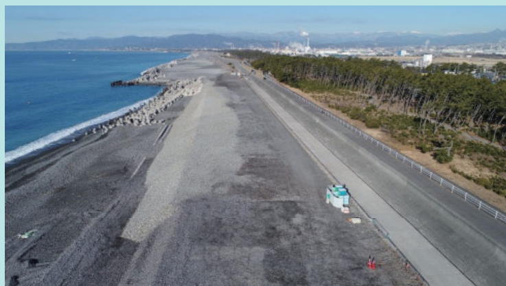
養浜施工の状況 (吉原工区、2017年度(平成29年度))
