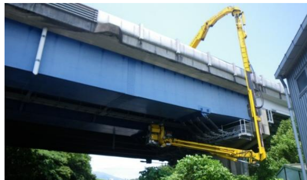
橋梁点検車による点検
