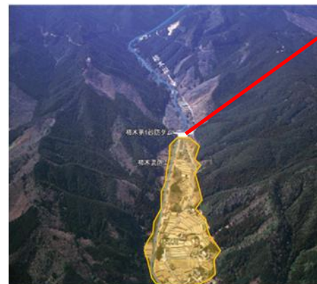
かきぎ 柿木第1砂防堰堤
