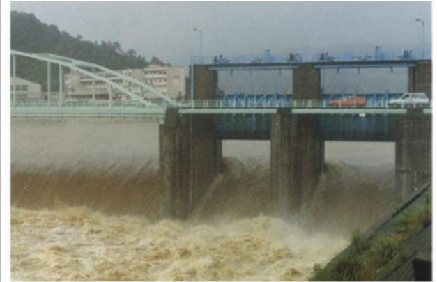
放水路の放流状況
