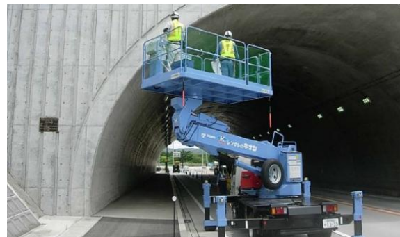
高所作業車によるトンネル点検
