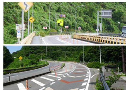
②国道246号県境付近は、大型車が多く急勾配かつ急カーブが連続する
