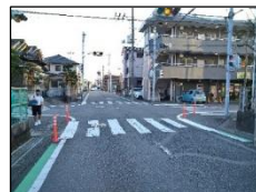
歩行空間整備（カラー舗装）
