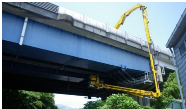
橋梁点検車による点検
