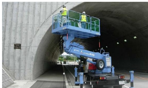
高所作業車によるトンネル点検
