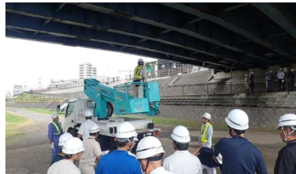
自治体向け橋梁点検研修（現地実習）
