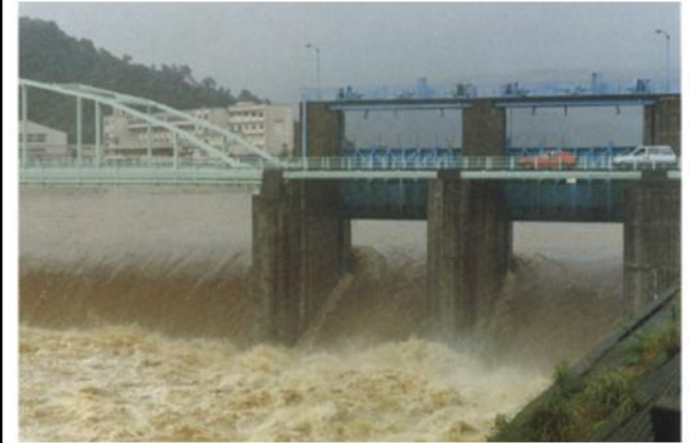
放水路の放流状況
