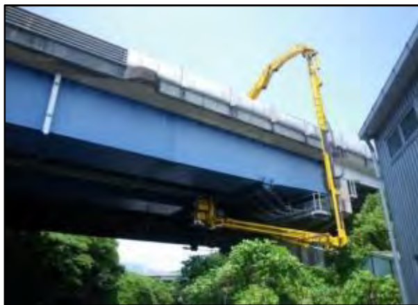
橋梁点検車による点検
