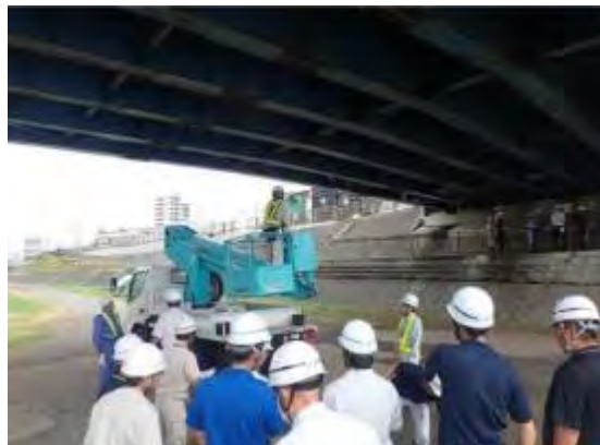
自治体向け橋梁点検研修(現地実習)
