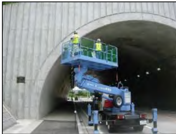
高所作業車によるトンネル点検
