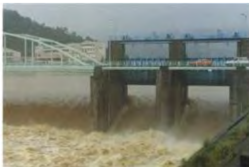
放水路分流堰の放流状況
